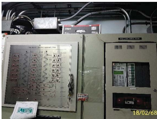
แผงควบคุมระบบสัญญาณแจ้งเพลิงไหม้
